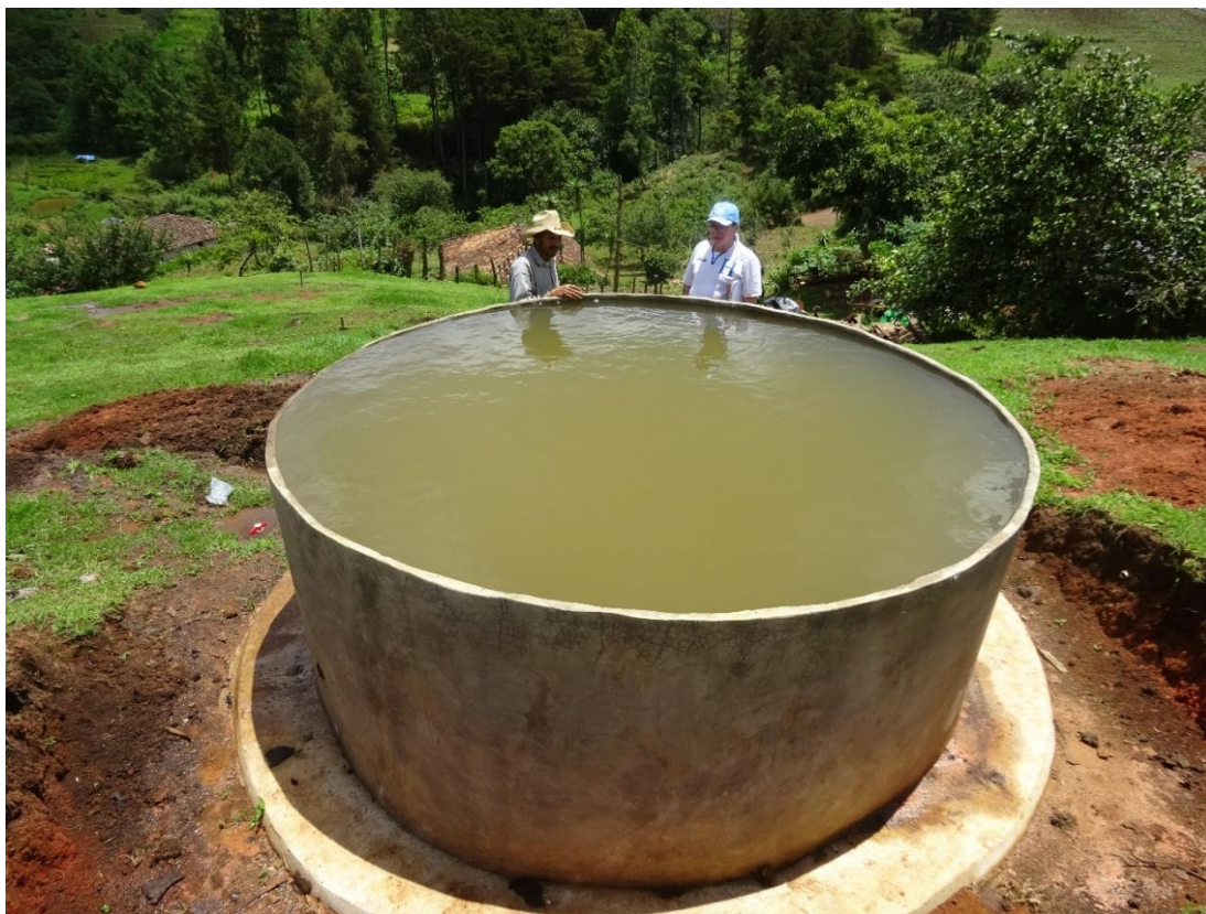
Ilustración 10 Tanque de almacenamiento de agua para fincas, Monte Copado, Santa Elena
